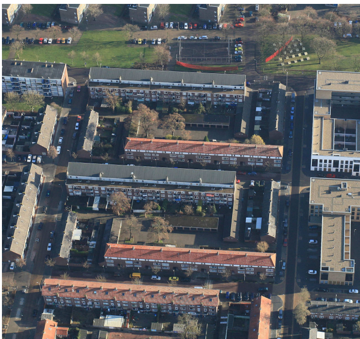
Afbeelding 2.5 Voormalige bebouwing 2e fase en bestaande bebouwing 3e fase, boven de Copernicuslaan en rechts Signatuur
