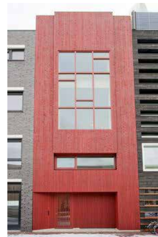
afwisselend kleurrijke gevels:
