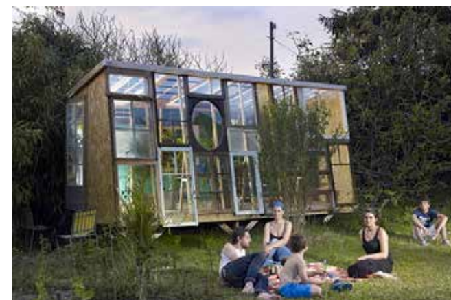
hergebruik van bestaande bouwonderdelen voor nieuwe samenstelling:
