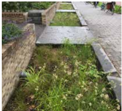
1. Gescheiden afvoer van hemelwater
