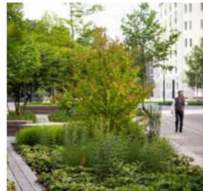
3. Wadi's met rijke beplanting als waterrijk park voor infiltratie en vertraagde afvoer van hemelwater
