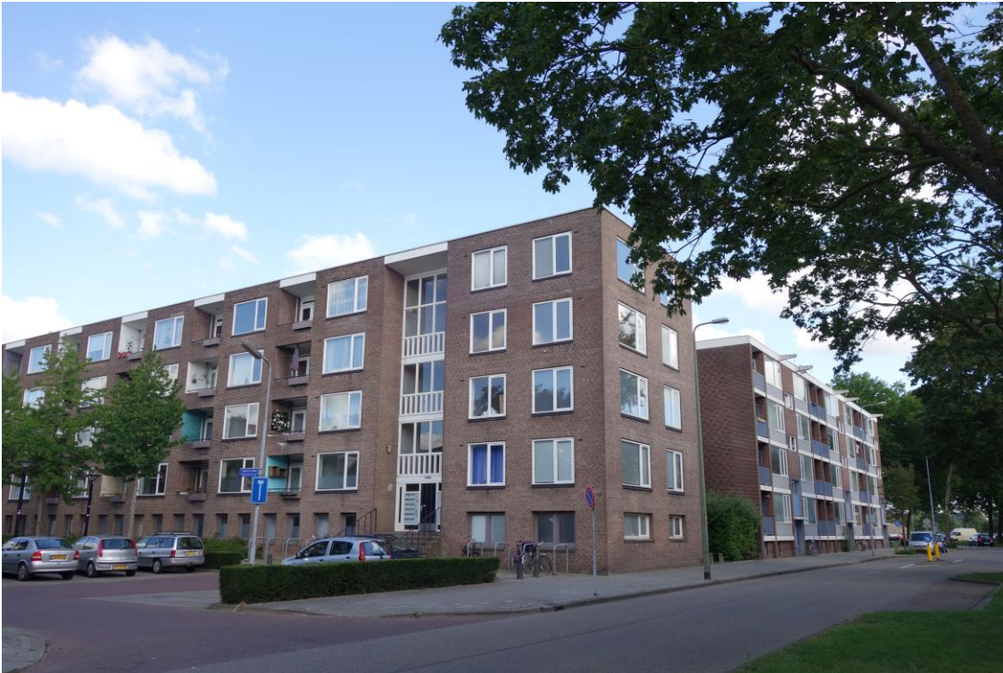
Afbeelding 1.1.2: De appartementen aan de Copernicuslaan zijn als eerste gesloopt
