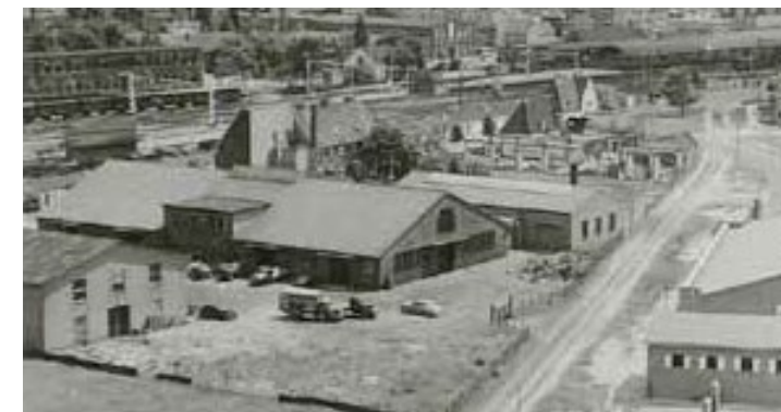
De veilinghal. Links de gesloopte en vervangen grenco hal
