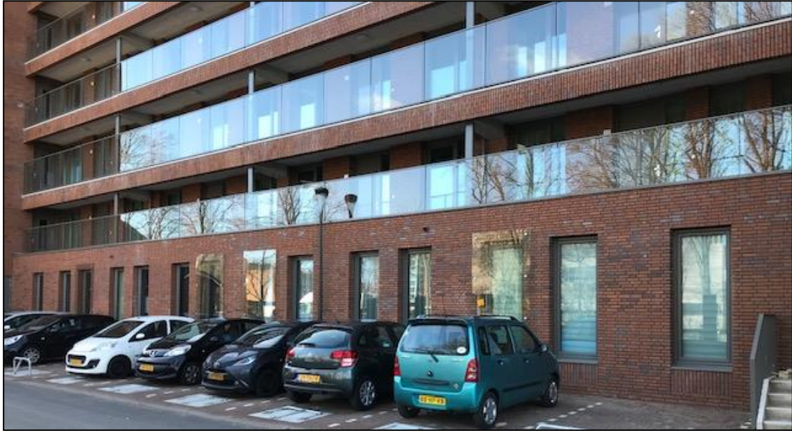
Figuur 5.2: Impressie balustradescherm galerij bouwplan Willemspoort
