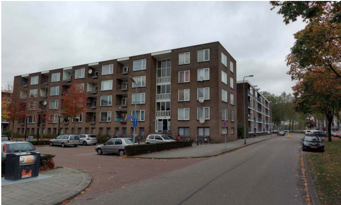
Afbeelding 1: twee appartementencomplexen aan de Copernicuslaan die in fase 1 vervangen worden
